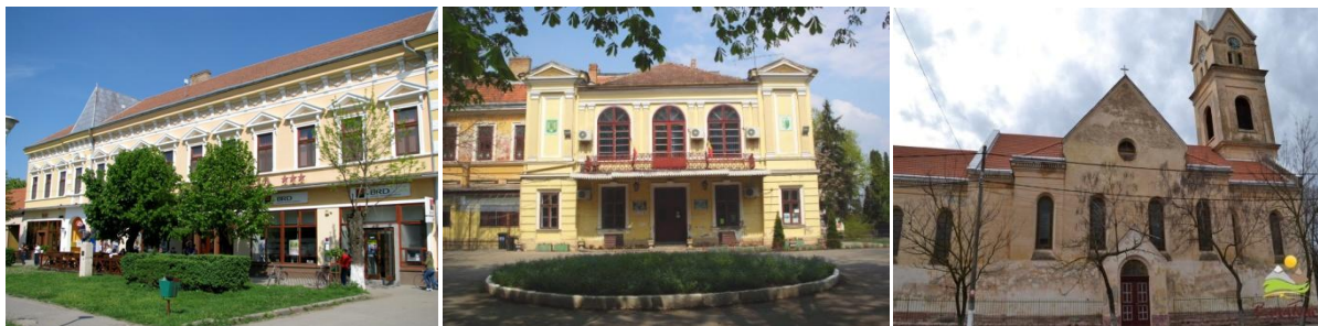
Fig. 9.1. Clădiri specifice zonei centrale a Jimboliei
