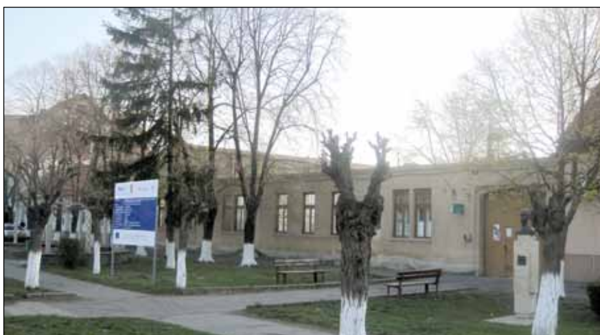
Șantierul de reabilitare a ambulatoriului spitalului (Policlinica)
