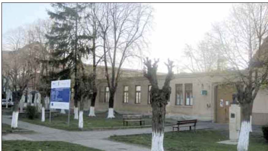
Șantierul de reabilitare a ambulatoriului spitalului (Policlinica)
