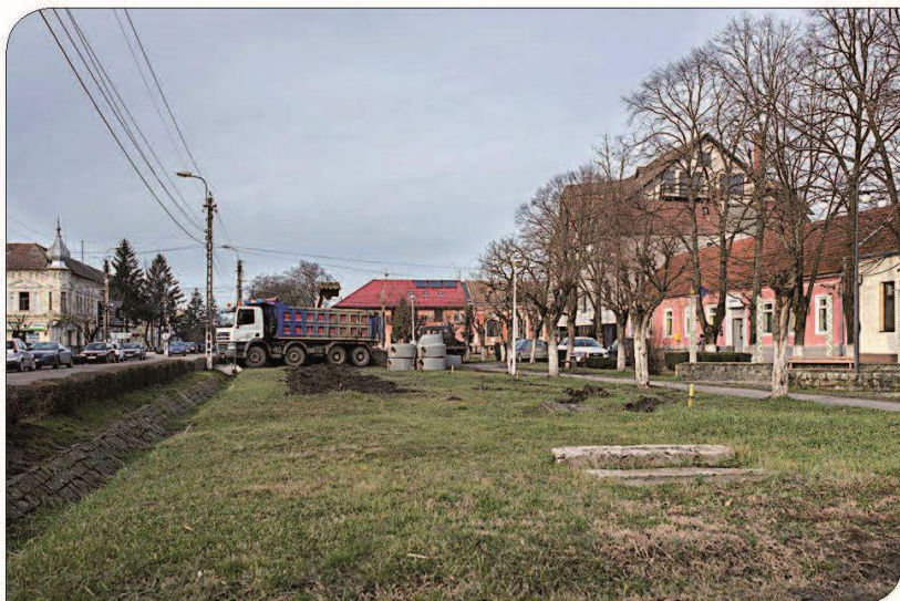
2016. Au reînceput lucrările de canalizare în centrul oraşului
