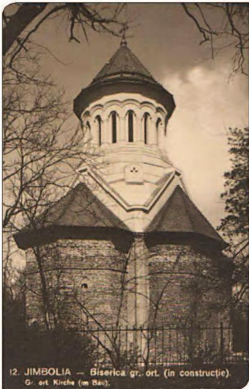
Biserica ortodoxă în construcție.
