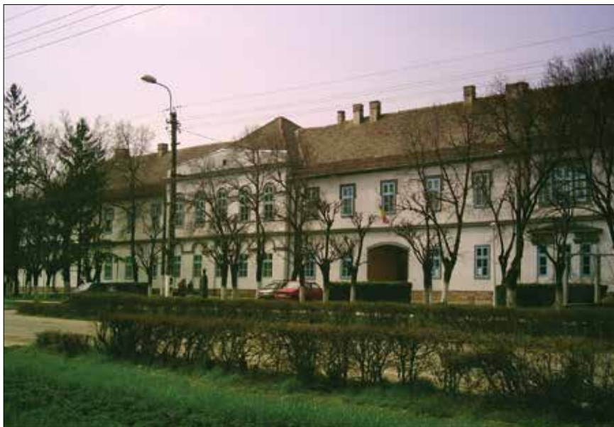
Clădirea din centru a Liceului tehnologic „Mihai Eminescu”
