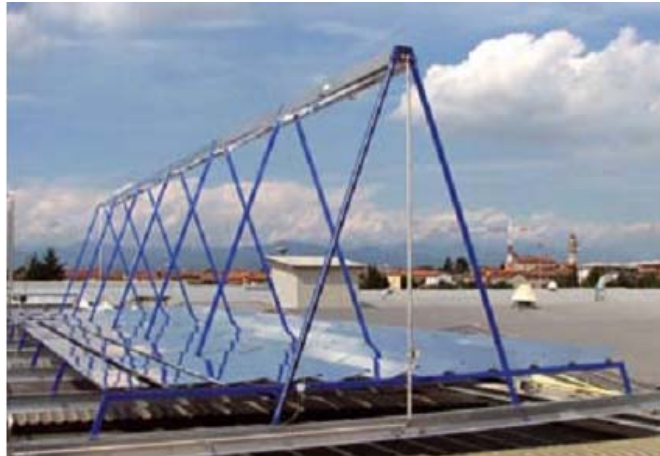
Figura 10.13: Colector solar pe baza de apa-amoniac pentru masini de racire prin absorptie
